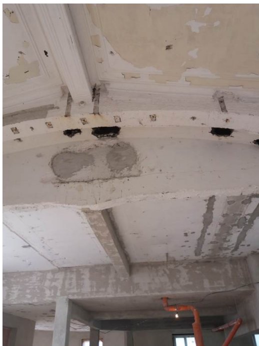
Felső szintű leendő étterem belső szerkezete
