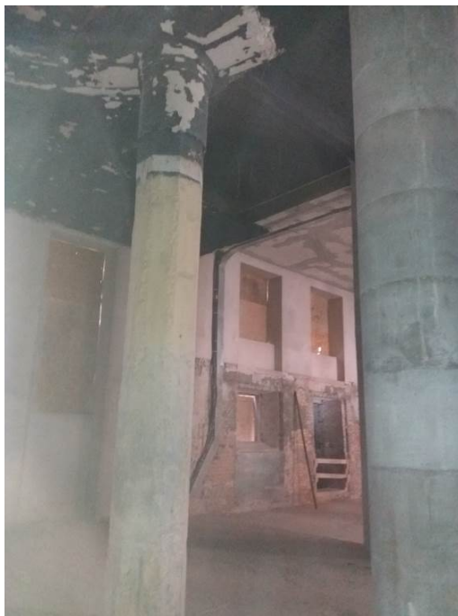
Földszint kétszintes oszlop megerősítés és állmennyezet
