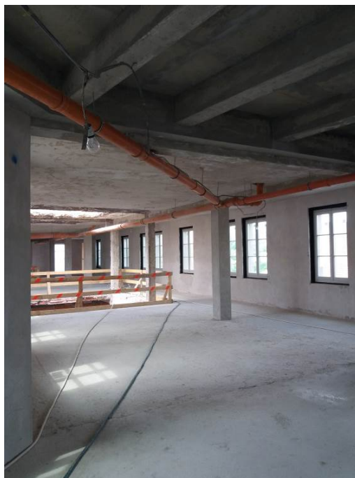
Közbenső szint a Csaba utca felől – ideiglenes csapadék vízelvezetéssel
