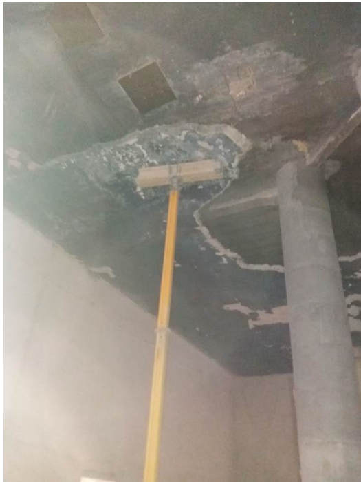
Földszint kétszintes oszlop megerősítés és állmennyezet
