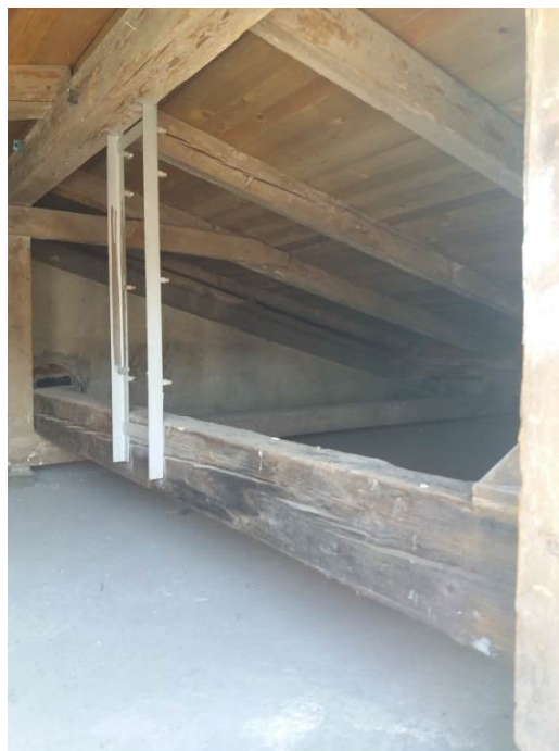
Felső szintű leendő étterem ácsszerkezet cseréire vár II.ütemben
