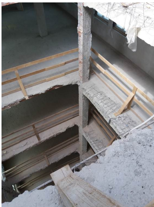
és új lépcsőházhoz földemáttörés
