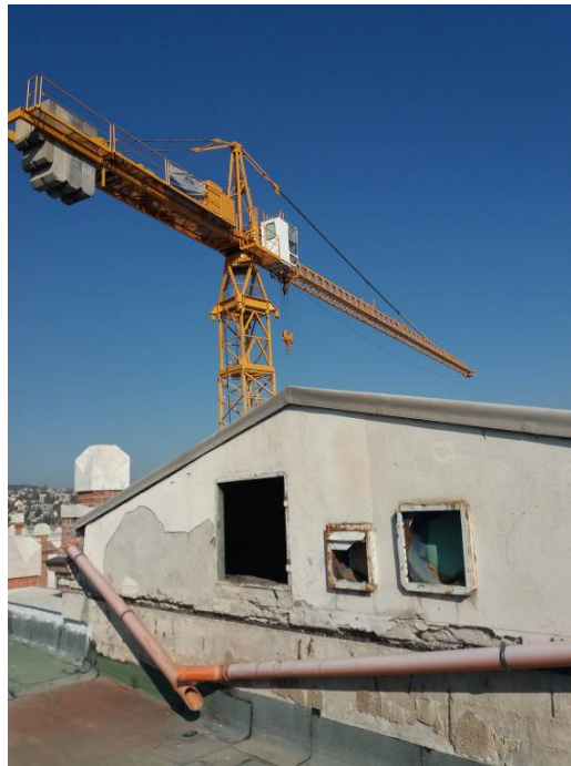
Ideiglenes csapadékvíz elvezetés
