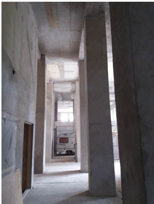
Földszinti megerősítés és Liftakna
