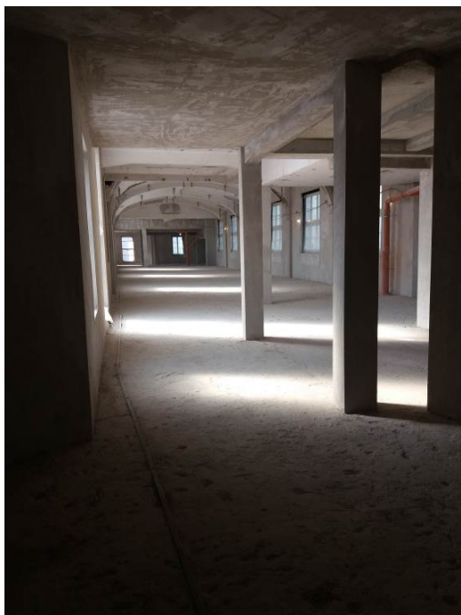
Felső szintű leendő étterem belső szerkezete
