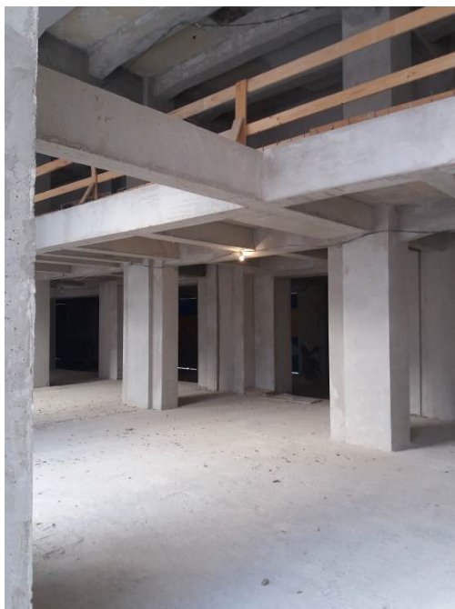
Földszinti tartószerkezeti megerősítés
